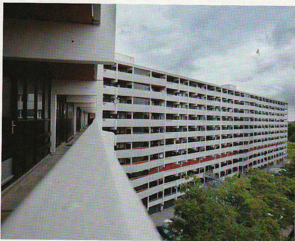
HOEZO ONAFHANKELIJK? GELDERSHOOFD, FLATCOMPLEX IN DE BIJLMER (502 WONINGEN)
