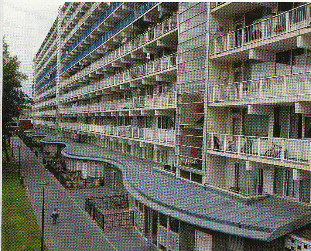
GEEN TOESTEMMING HET COMPLEX HOGEVECHT (234 FLATS) IN DE BIJLMER
