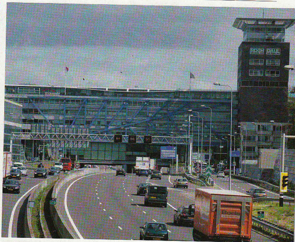
BRUGGEBOUW DE EIGEN BEHUIZING VAN ROCHDALE BOVEN DE RINGWEG VAN AMSTERDAM
